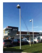
Cilindrische mast met uithouder (special) thermisch verzinkt
